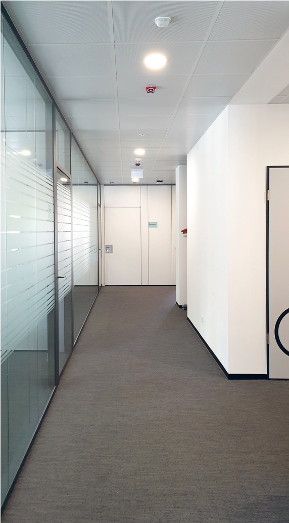
Flur des Gebäudes mit Sichtschutzwänden links
